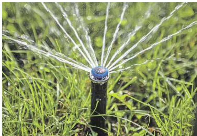
Sprinklery stříkají. Parky mívají nainstalovaný systém zavlažování pomocí sprinklerů. Chytré zavlažování je vysune jen tehdy a tam, kde je vlaha potřeba.
